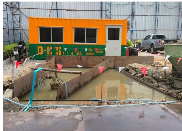
ภาพที่ 31 บ่อกักตะกอนน้ำเสียจากการล้างล้อรถ
